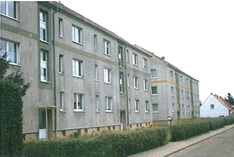
3-geschossiger Wohnungsbau an der Dorfstraße (Wohnblöcke Dorfstraße 15,16 und 17,18)
