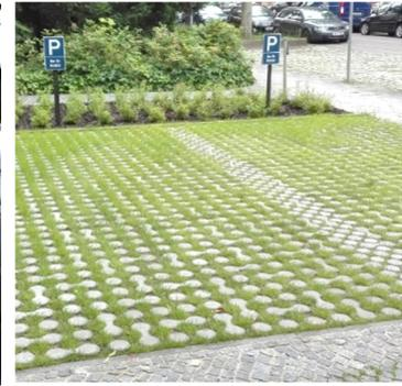
Abbildung 12: Beispiel Rasenkammer-/Rasengitterstein
