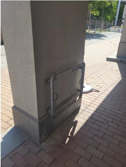
Abbildung 31: Alternative Fahrradabstellanlagen für Hauswände
