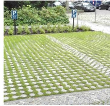
Abbildung 12: Beispiel Rasenkammer-/Rasengitterstein
