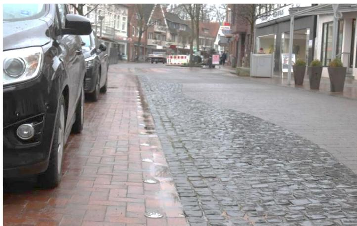
Abbildung 14: Beispiel der Stellplatzmarkierung durch Oberflächenwechsel
