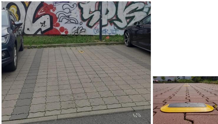
Abbildung 15: Beispiel eines Bodensensors zur Einzelstellplatzerfassung
