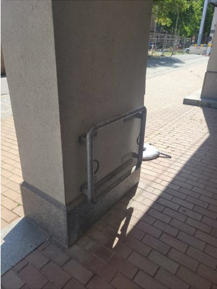
Abbildung 31: Alternative Fahrradabstellanlagen für Hauswände
