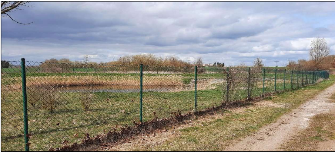
Abbildung 05: Blick am 09.04. nach NW auf das Regenwasserauffangbecken.
