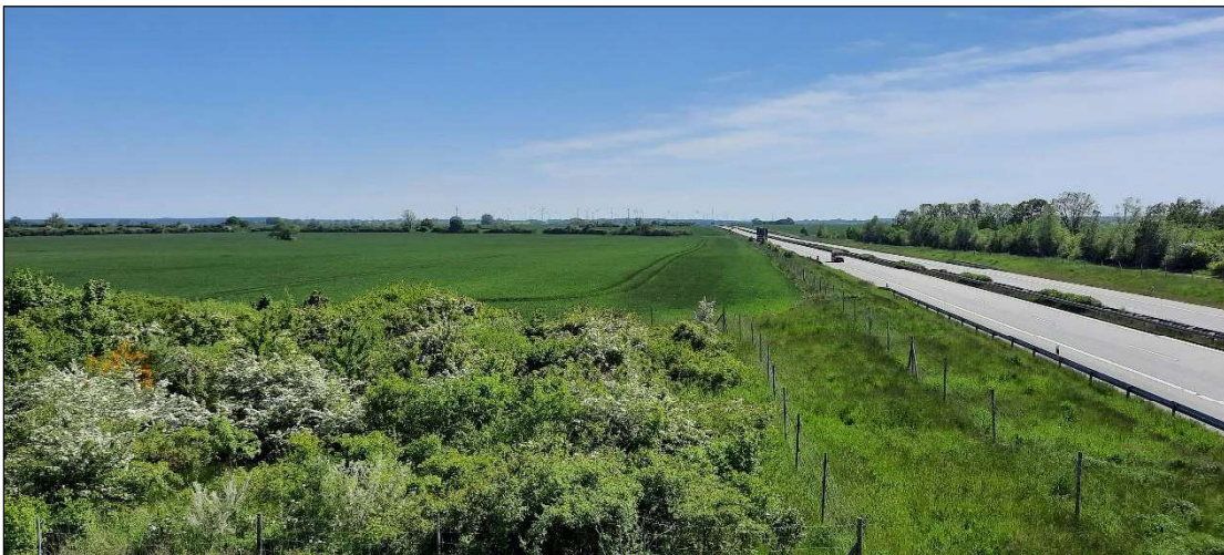
Abbildung 07: Blick am 03.06. von der Autobahnbrücke nach Süden.
