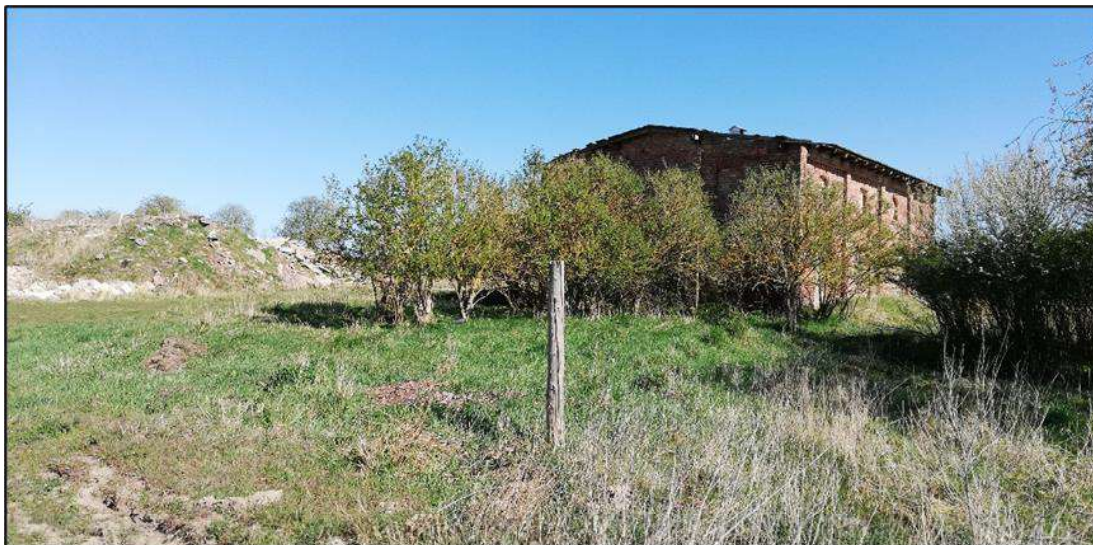
Abbildung 27: Blick nach Südosten auf das alte Wirtschaftsgebäude.
