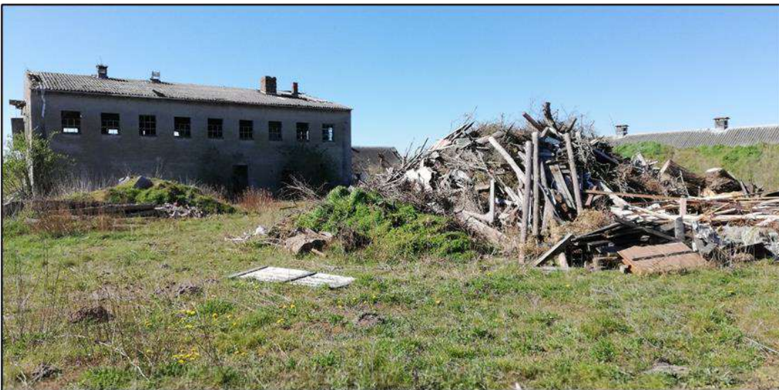
Abbildung 31: Blick nach Süden über den südlichen Hof.
