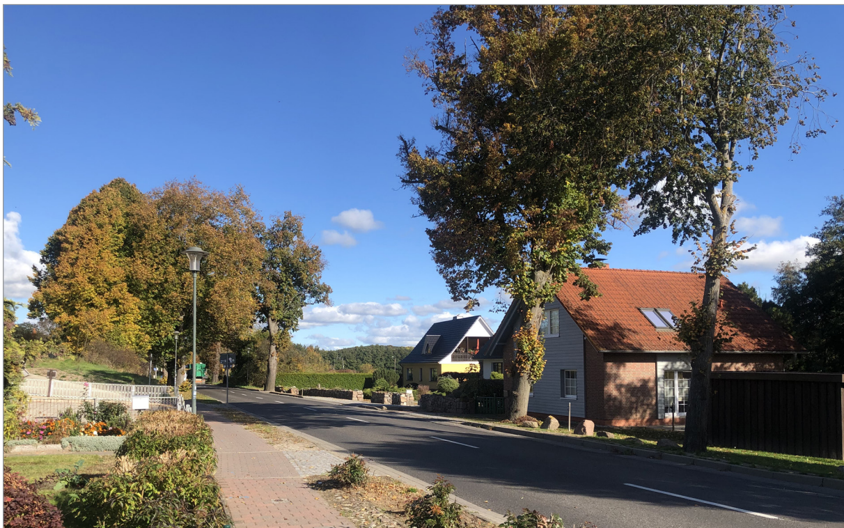
Abbildung 2-1 Stralsunder Straße | Blickrichtung Norden | Quelle: eigene Aufnahme HOFFMANN-LEICHTER
