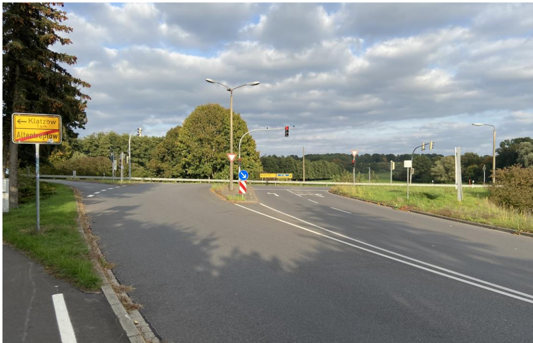
Abbildung 2: Mündungsbereich Stralsunder Straße/L 35 unmittelbar nördlich des Planareals
