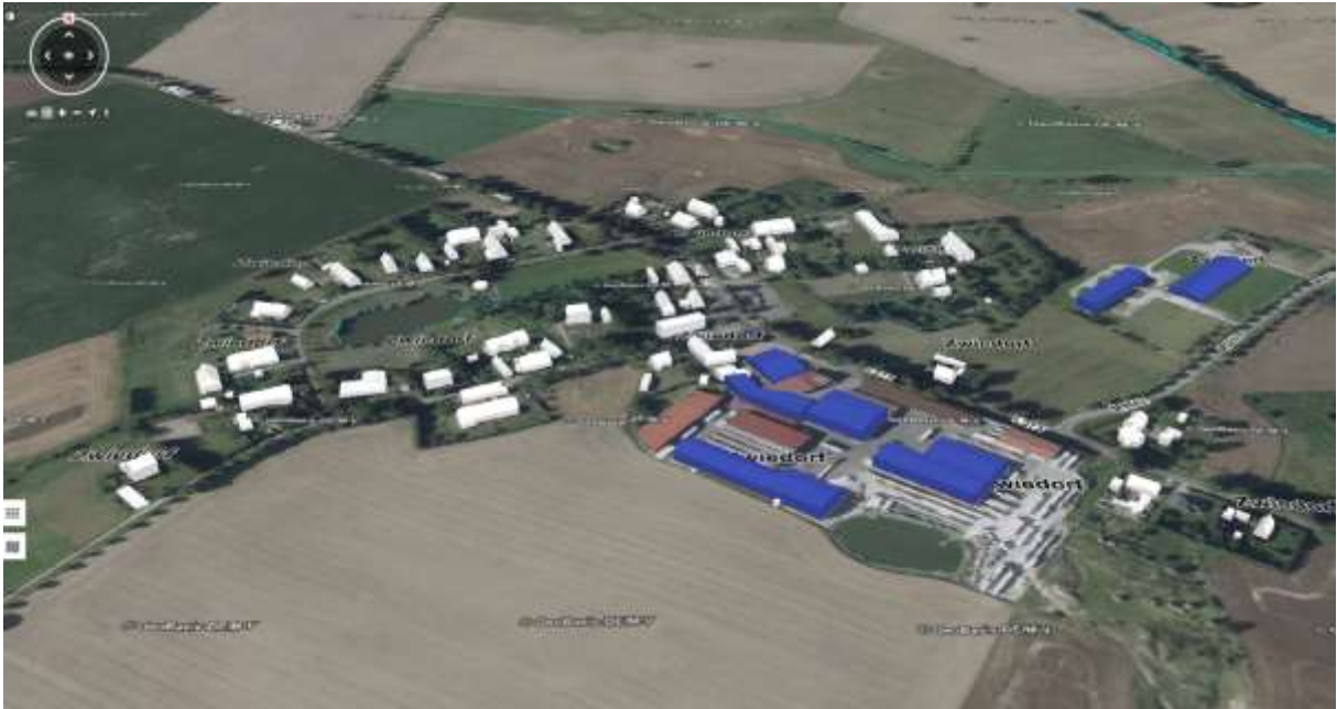
Abbildung 6 Zwiedorf mit gekennzeichnetem Gewerbegebiet (südlich) und Hähnchenmastanlagen (nördlich)
