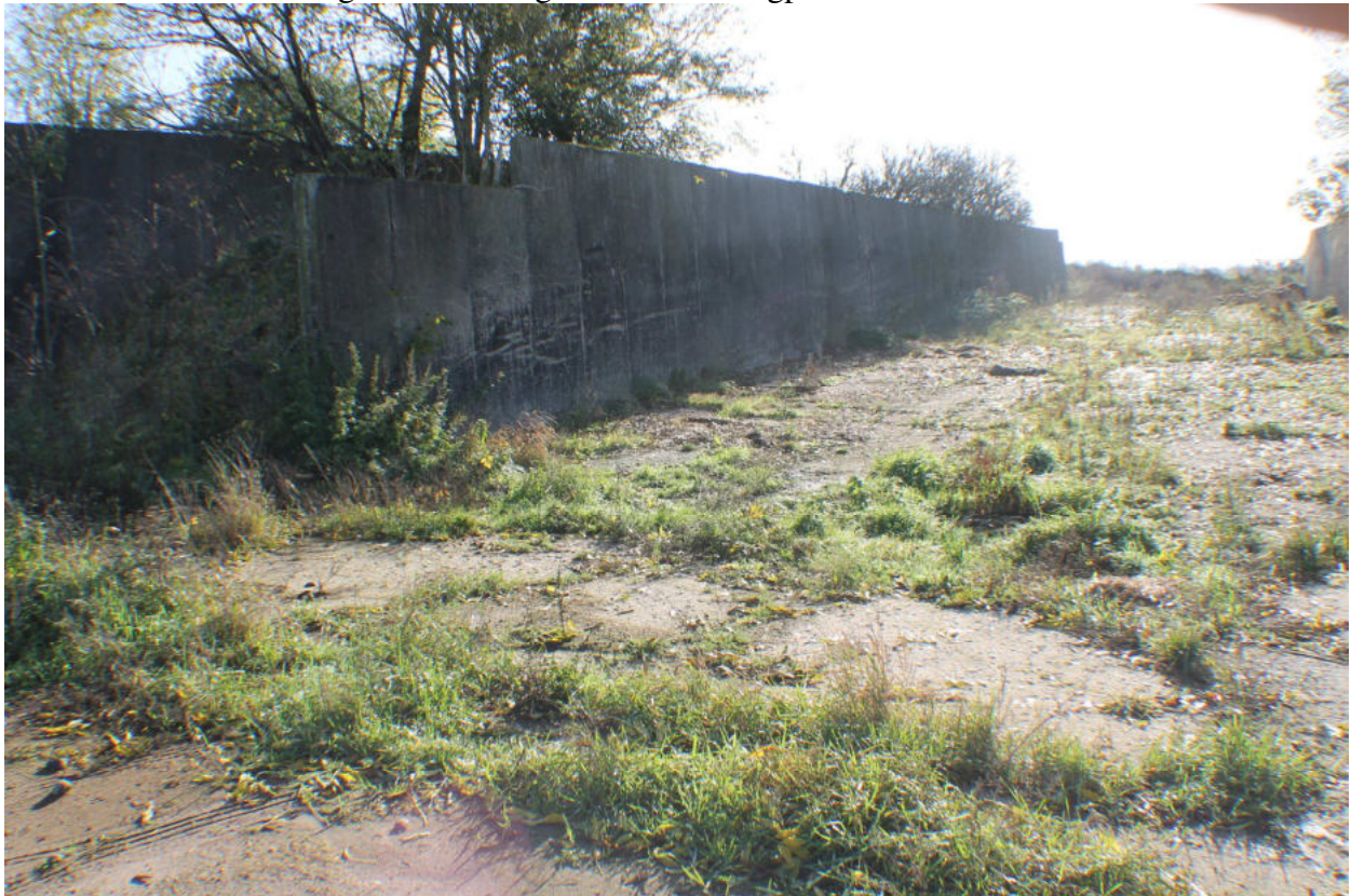
Großflächige Verdichtung betonierte Dungplatte im südlichen Bereich
