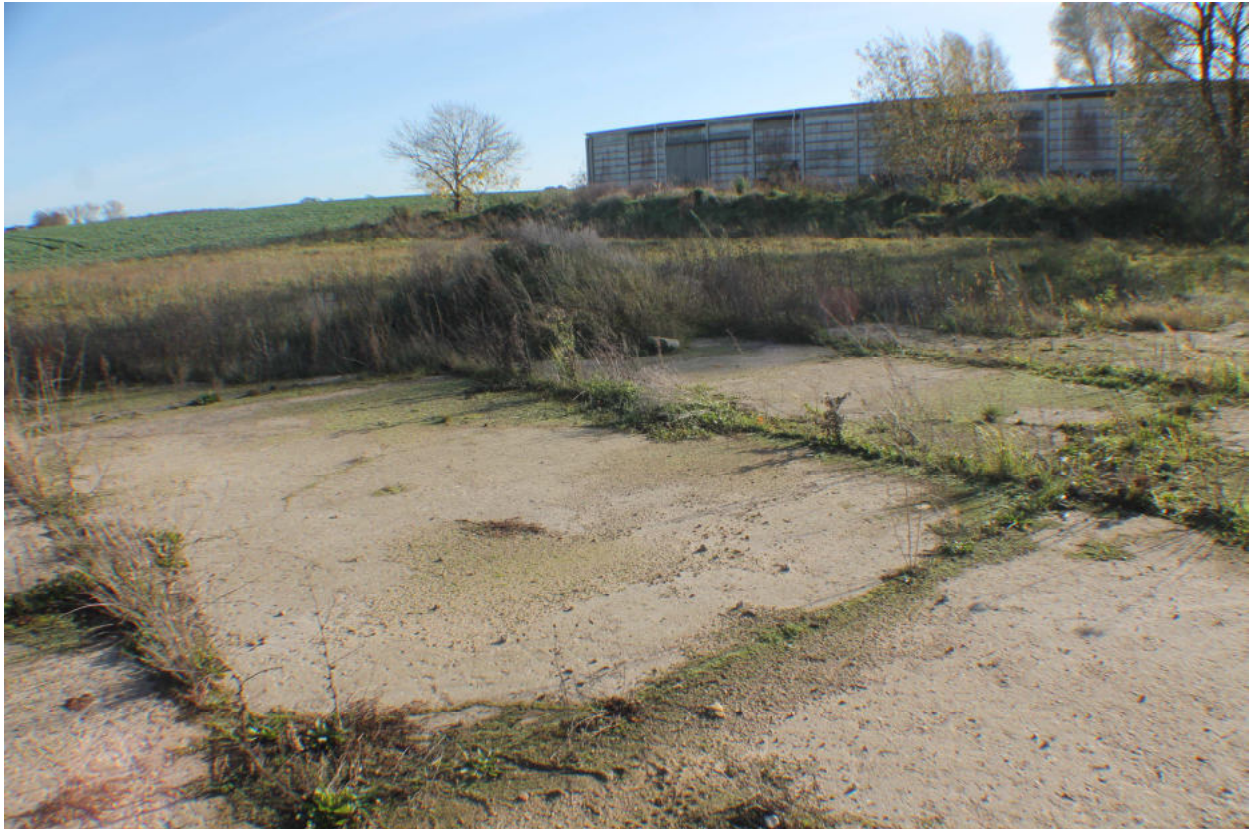
betonierte nördliche Freifläche
