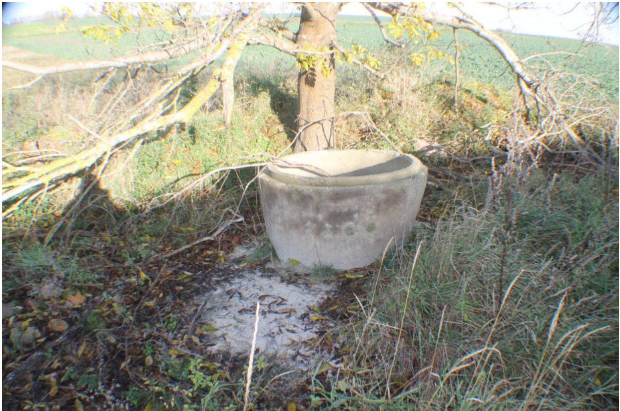
Sickerschächte im Gelände
