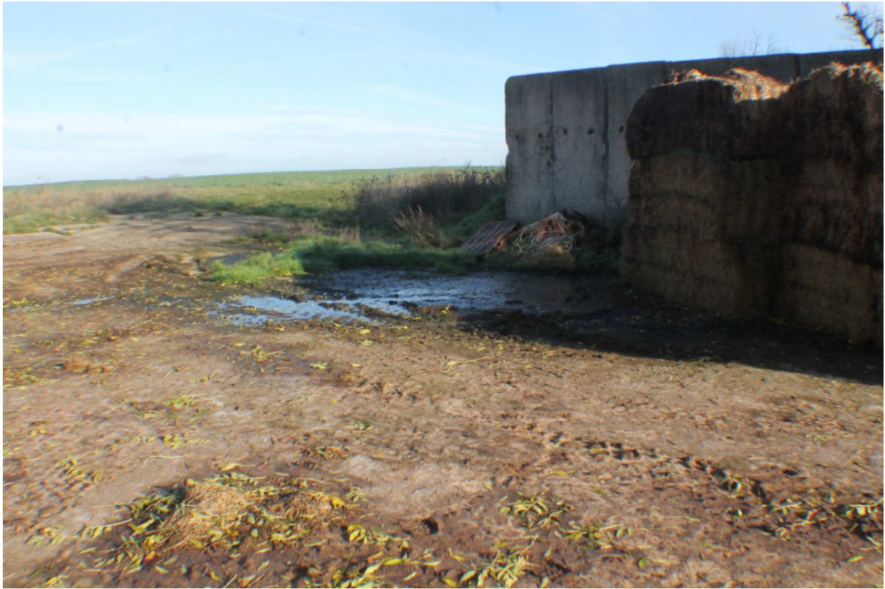
Verdichtete teils betonierte Flächen im mittleren Bereich
