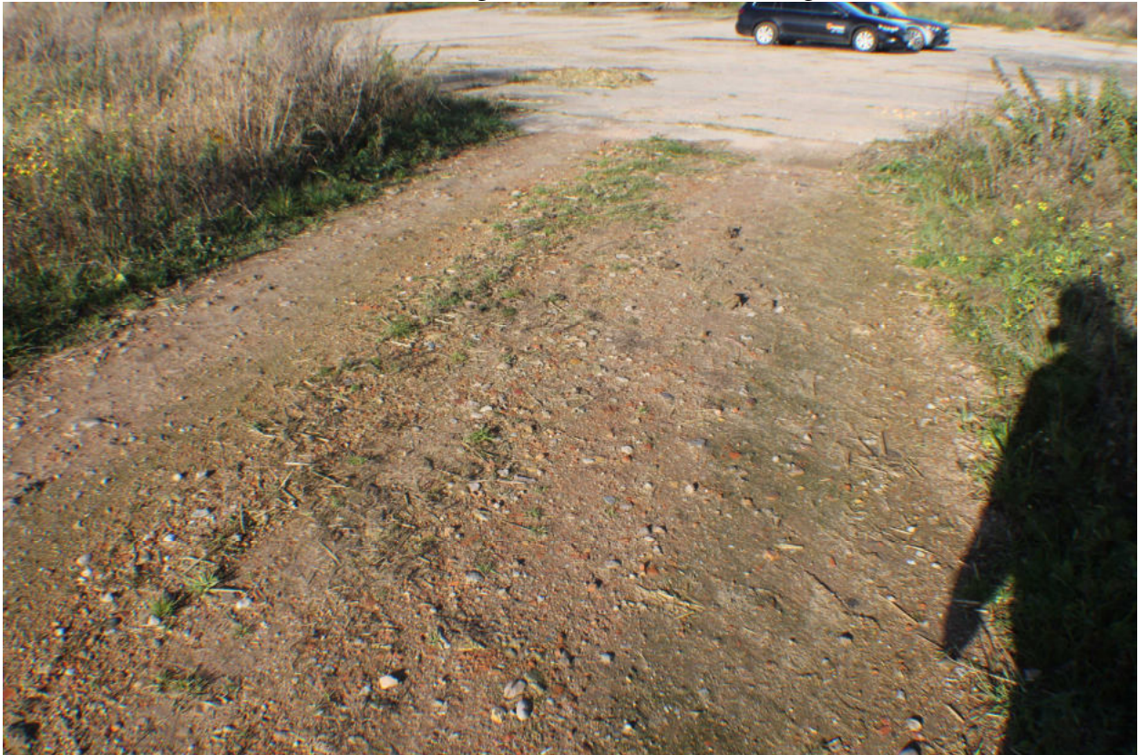
Verdichteter geschotterter Wirtschaftsweg
