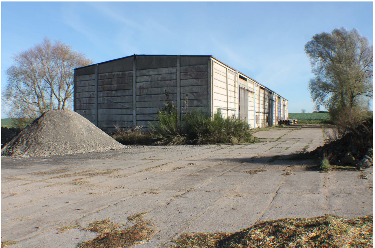
Abb.: Foto des Geländes mit Gebäudebestand (Hauptgebäude)
