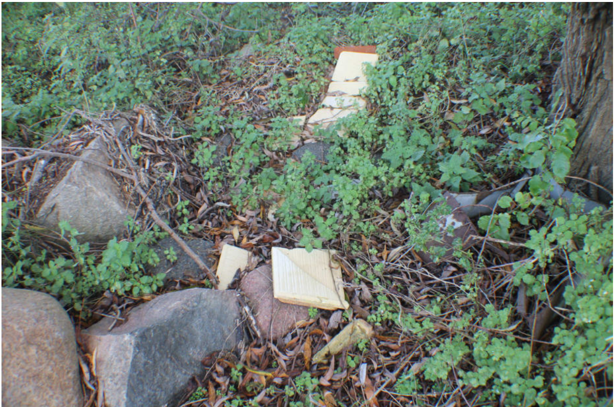
Schutt- und Baustoffreste im Boden
