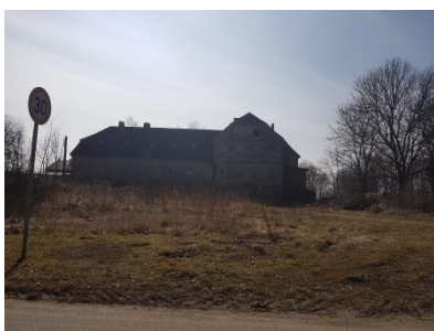
OT Kalübbe, Ortsrand Umspannwerk
